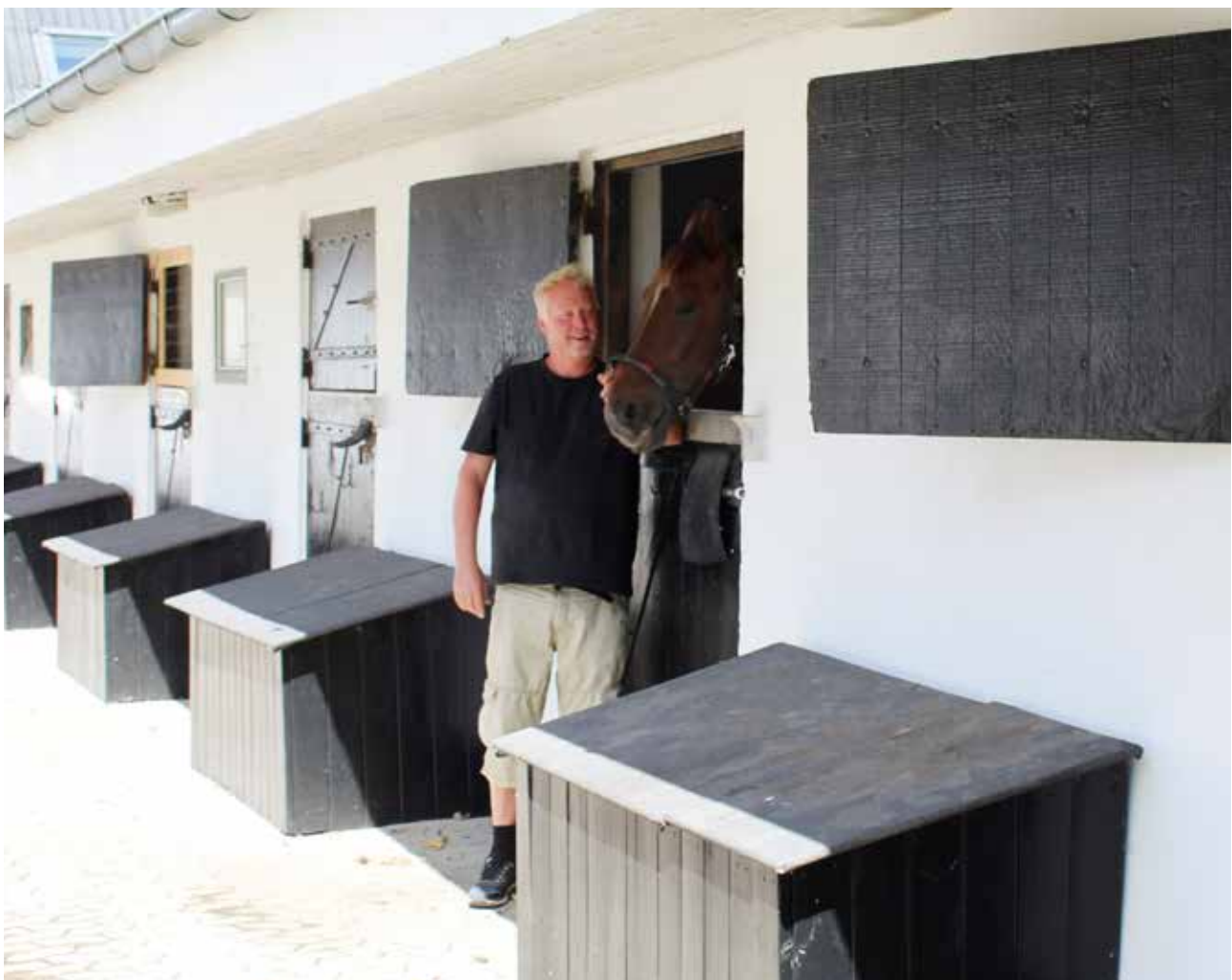
Kim Madsen har bygget denne fløj, hvor de seks travere kan stikke hovedet og ud få frisk luft.
